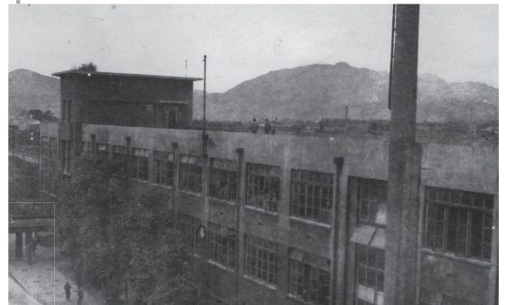
黒塗りが残る校舎(昭和21年、四条商業学校) ※戦時中に空襲を避けるため塗られた。後の四条中学校。
